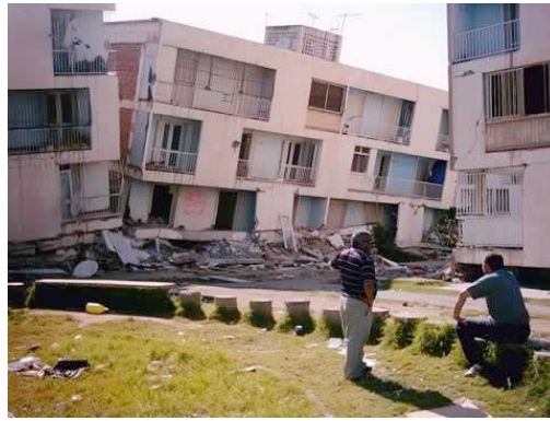
Figure 7 : Effondrement de bâtiments suite au séisme de Boumerdès 2003, (A.Zoreik, habitant de Boumerdès).
